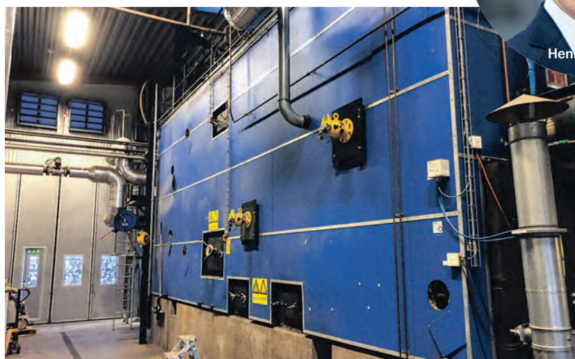
En vanlig fjärrvärmepanna har byggts om för att producera biokol.
