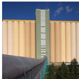
Upprustning spannmålsinfrastruktur Köping
