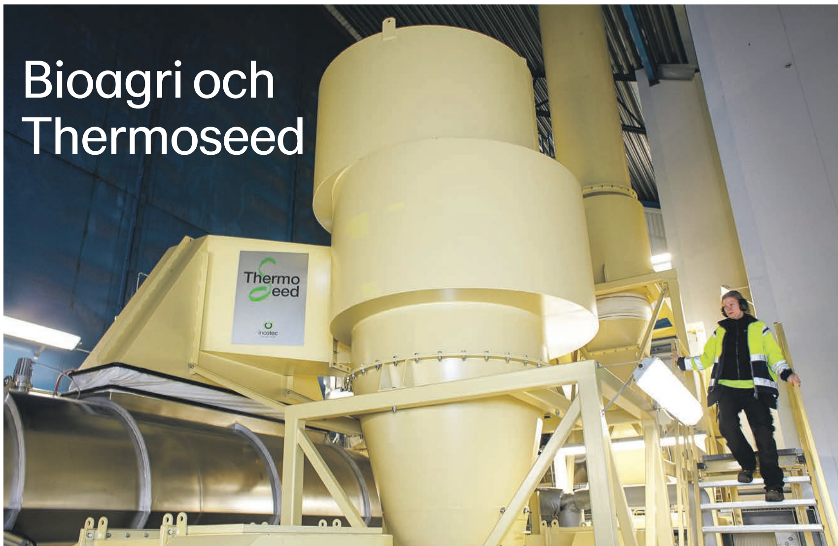
Thermoseedanläggningen i Eslöv.
